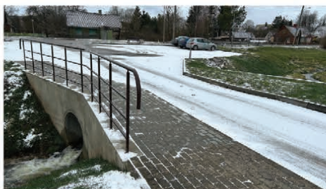
Vandens pralaidos remontas Taujėnų sen.
