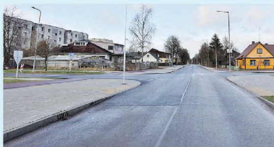
Antakalnio g. rekonstrukcija
