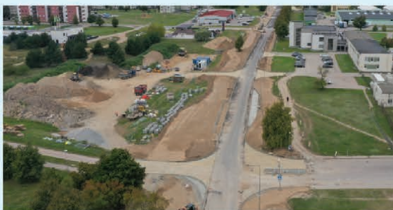
Antakalnio g. rekonstrukcija
