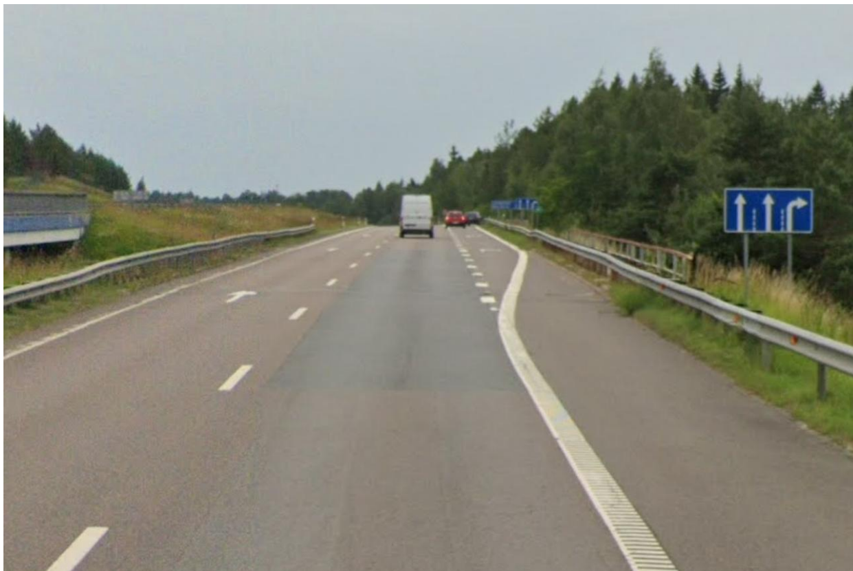
7 pav. Objekto vieta (vaizdas į projektuojamą viaduką)
