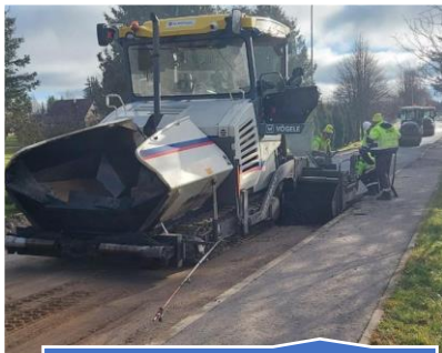
Dalies Liepų g. asfaltavimas
