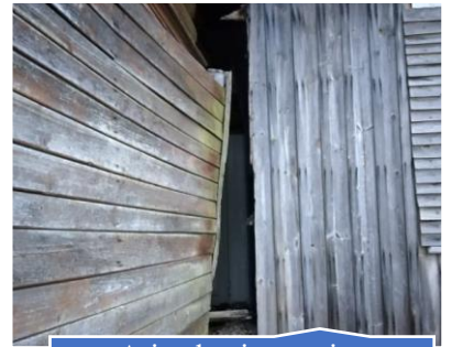
Atitrūkusi senosios klebonijos siena
