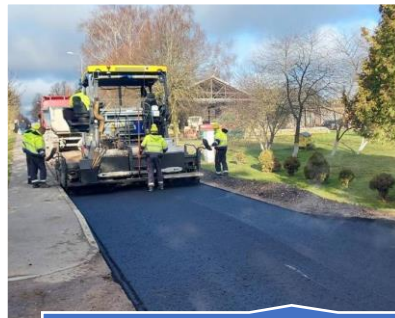
Dalies Liepų g. asfaltavimas
