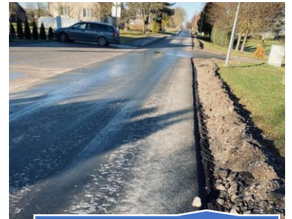
Dalies Liepų g. asfaltavimas
